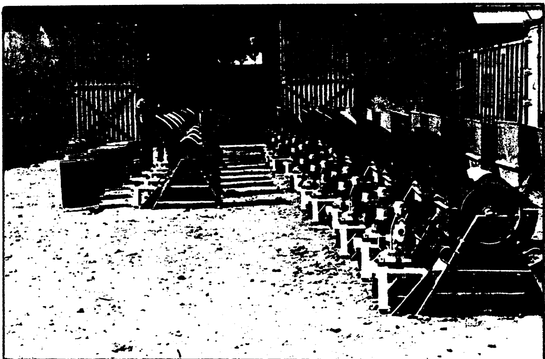
Figure 4: Assemblage local des batteuses Ricefan à l'atelier de Niono, Mali.
